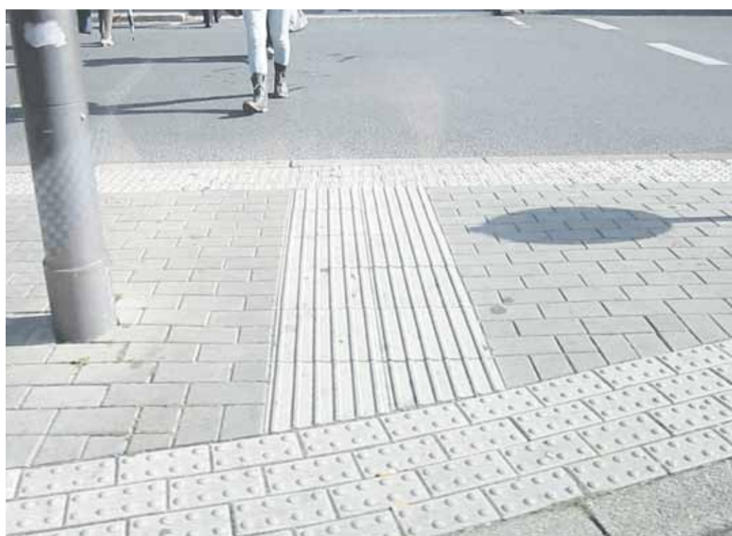
Pflasterungen mit erhabenen Noppen und Rillen erleichtern die Orientierung
